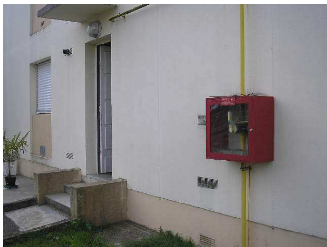
accès aux logements de fonction côté EST N° 3-4-6 7
