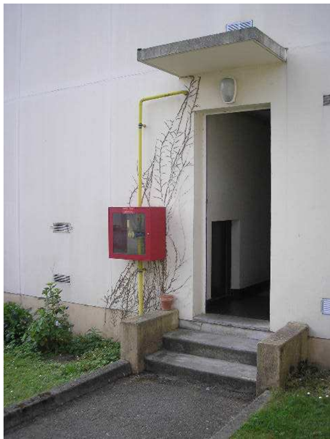
accès aux logements de fonction côté ADMINISTRATION
